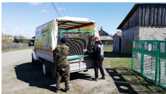
Установка сеток, 11 мая 2023г.
